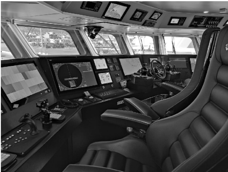
Überwachungsausrüstung auf der Brücke der LS-920 (justice4pylos.org)
